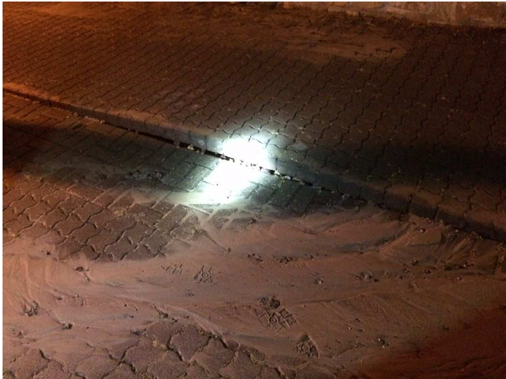
03.08.15 Wasserschaden Burgstraße Bild Feuerwehr
